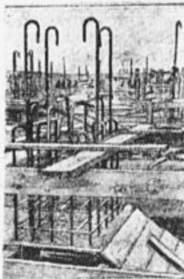
Закладка новой электростанции в Брянске.
